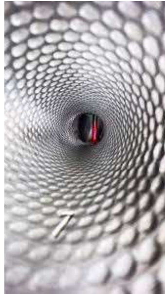
Imagem 7 – retrabalho de dutos tipo “Dimple”
